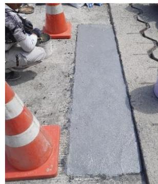
アルファテック110E(コンクリート色)は、速硬化性エポキシ樹脂に特殊骨材を配合した、高強度のエポキシモルタルです。強度の発現がきわめて速く、コンクリート、鋼材、アスファルトとの接着性能も高く、さらに、耐衝撃性能や耐摩耗性能にも優れています。そのため、短時間での施工を求められるアスファルト舗装の補修やマンホール周りの補修、道路埋設部の固定などに最適です。
